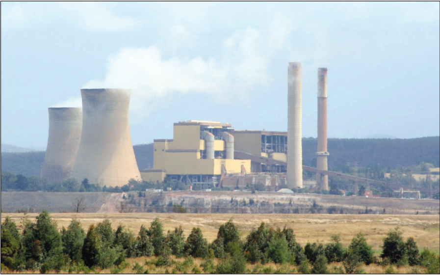
Một nhà máy điện khí tại bang Victoria, Australia
