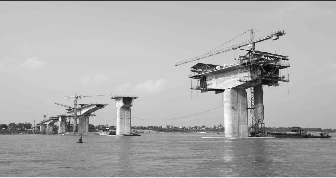
Cầu Vĩnh Thịnh thời kỳ còn đang thi công
