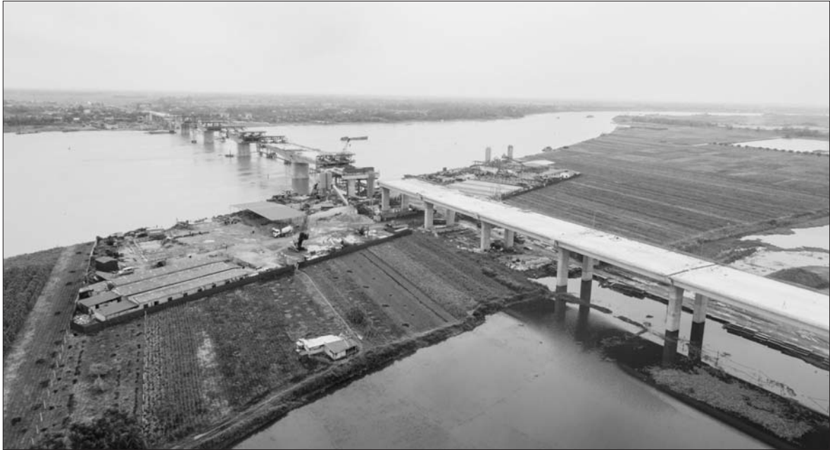
Cầu Hưng Hà trong thời gian thi công năm 2018
