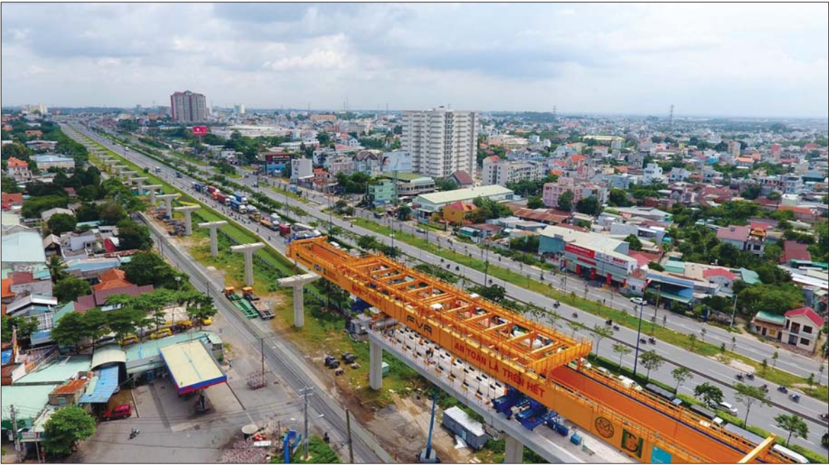
Dự án Tuyến đường sắt đô thị số 1 TP. HCM (tuyến Bến Thành - Suối Tiên)
