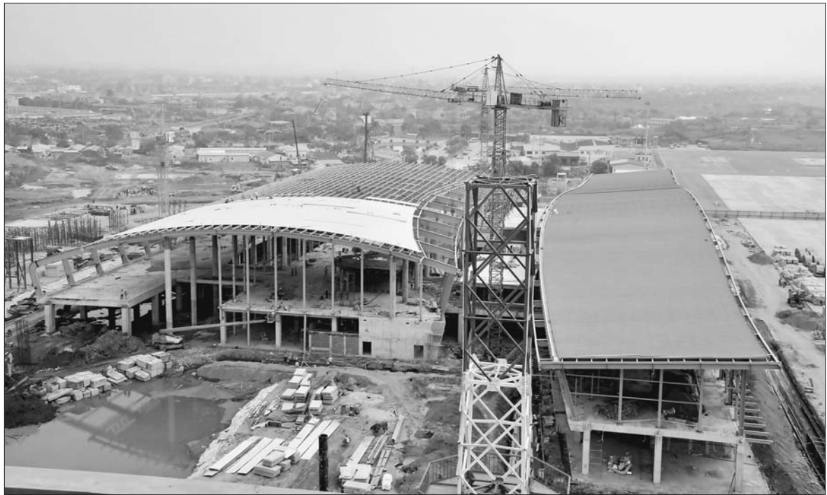
Dự án Đầu tư xây dựng mở rộng Khu bay của Sân bay Cát Bi (Hải Phòng)
