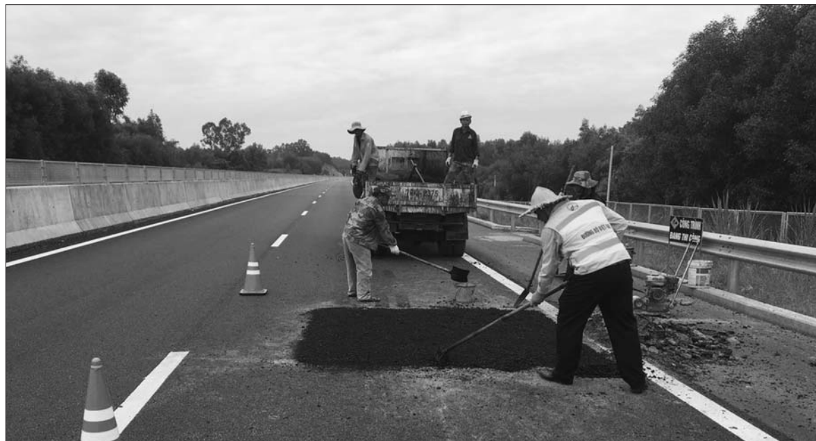
Dự án Nâng cấp mở rộng QL1 đoạn qua tỉnh Quảng Nam
