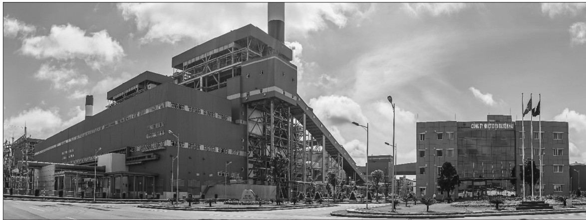
Trung tâm Điện lực - Nhà máy Nhiệt điện Duyên Hải
