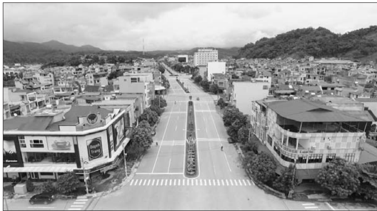
KTNN kiến nghị các Ban QLDA rút kinh nghiệm trong việc lập, thẩm định và phê duyệt dự toán các công trình Ảnh: TK
