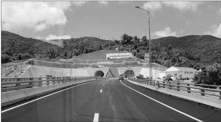
Hầm Đèo Cả - một trong những công trình sử dụng vốn TPCP Ảnh: TK
