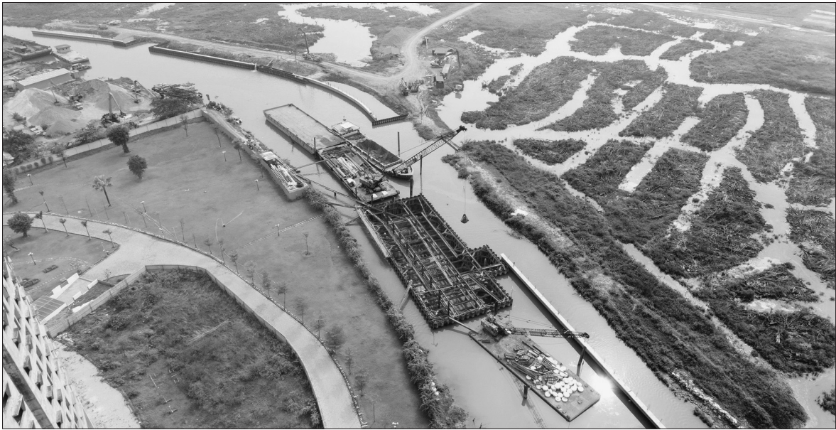
Dự án chống ngập 10.000 tỷ đồng ở TP. HCM phải tạm dừng thi công vì chậm giải ngân Ảnh: SOHA
