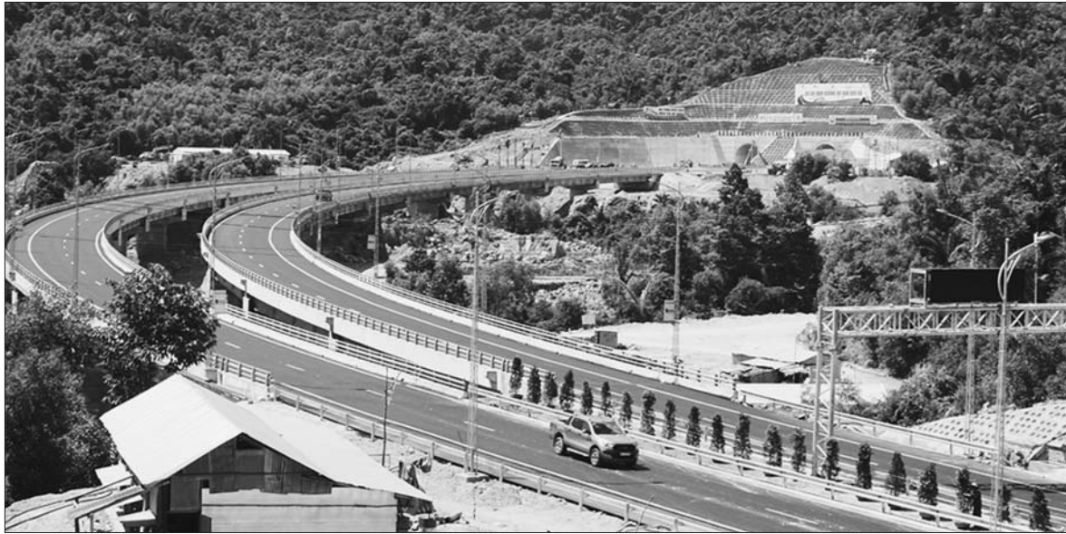
Nguồn vốn cho Dự án hầm đường bộ qua Đèo Cả còn chưa được sử dụng hiệu quả Ảnh: TS
