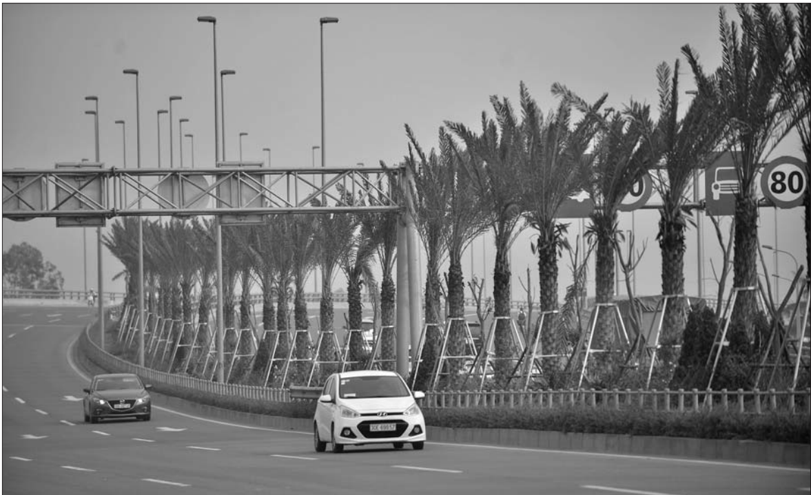
Dự án xây dựng đường nối từ sân bay Nội Bài đến cầu Nhật Tân phải điều chỉnh tăng TMDT hàng nghìn tỷ đồng Ảnh: TS
