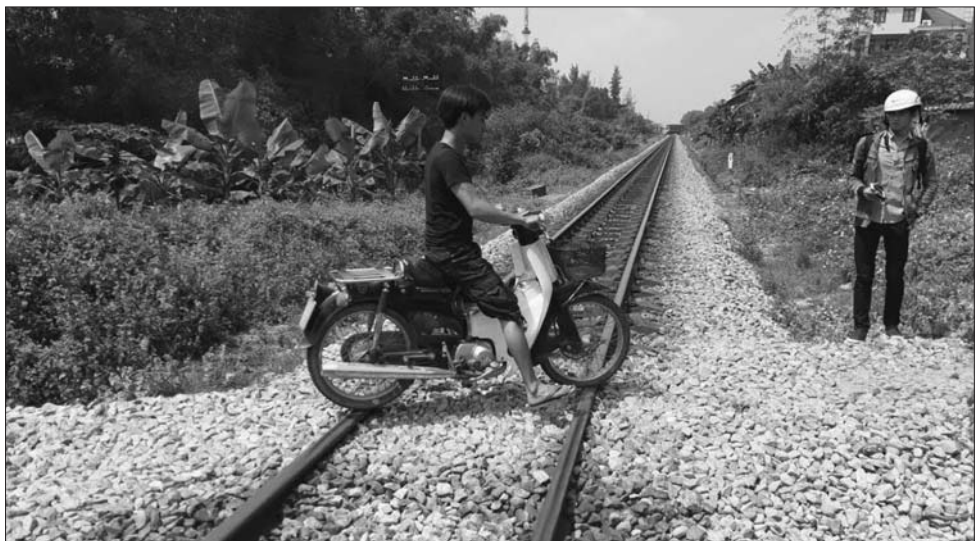
Tình trạng người dân cố tình vi phạm hành lang bảo vệ và tự mở lối đi dân sinh khiến an toàn đường sắt chưa được đảm bảo Ảnh: TK
