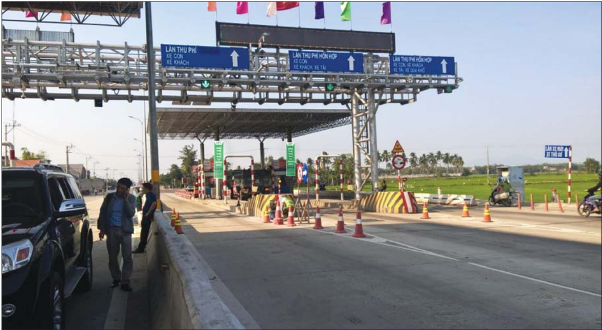
Trạm Hòa Phước (tỉnh Quảng Nam) đã chính thức triển khai thu phí tự động không dừng Ảnh: TK
